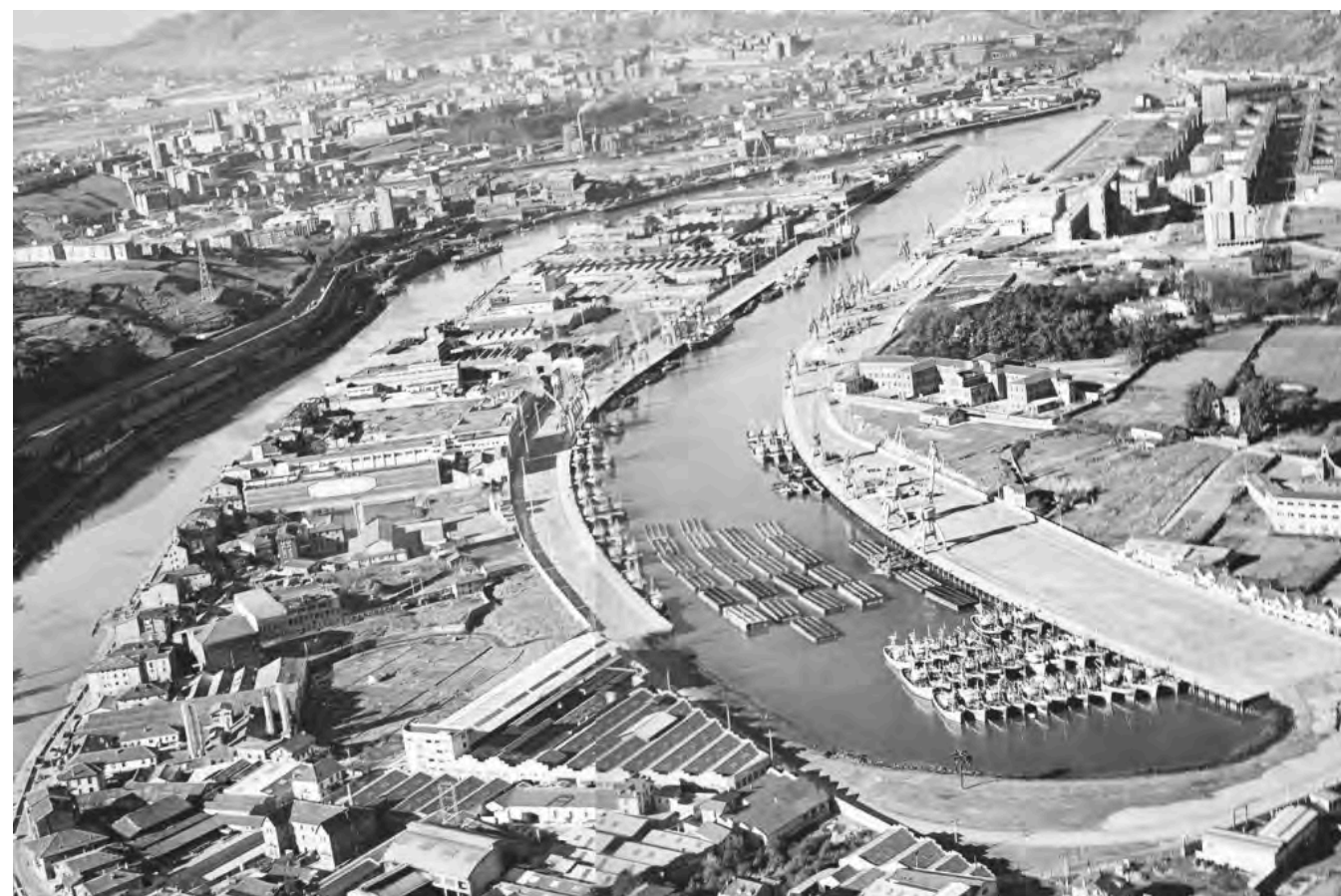
Foto. Canal de Deusto terminado
