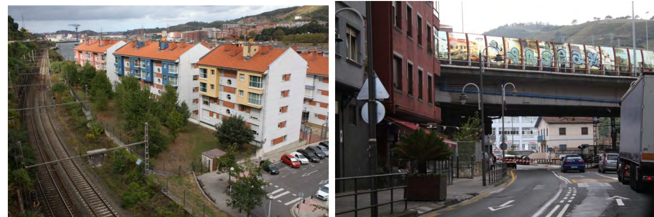
Fotos. Dos imágenes de la infraestructura ferroviaria en el lado izquierdo de la ría.
