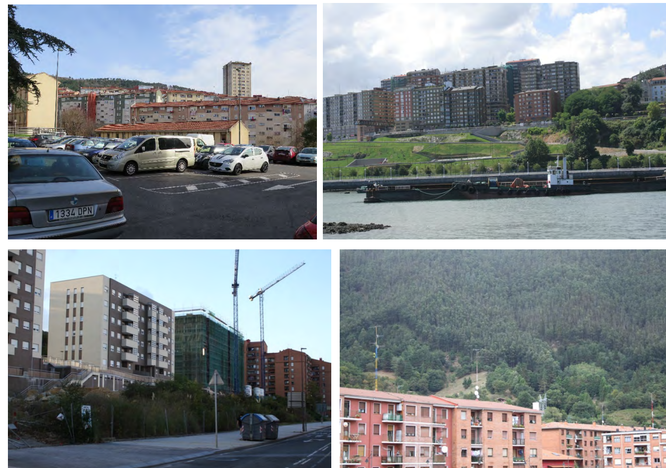
Fotos. Diversas zonas residenciales modernas (siglo XX y XXI) con diversas tipologías de bloques, dominando el paisaje urbano del ámbito de estudio y algunas de las bolsas de parking entre bloques abiertos.
