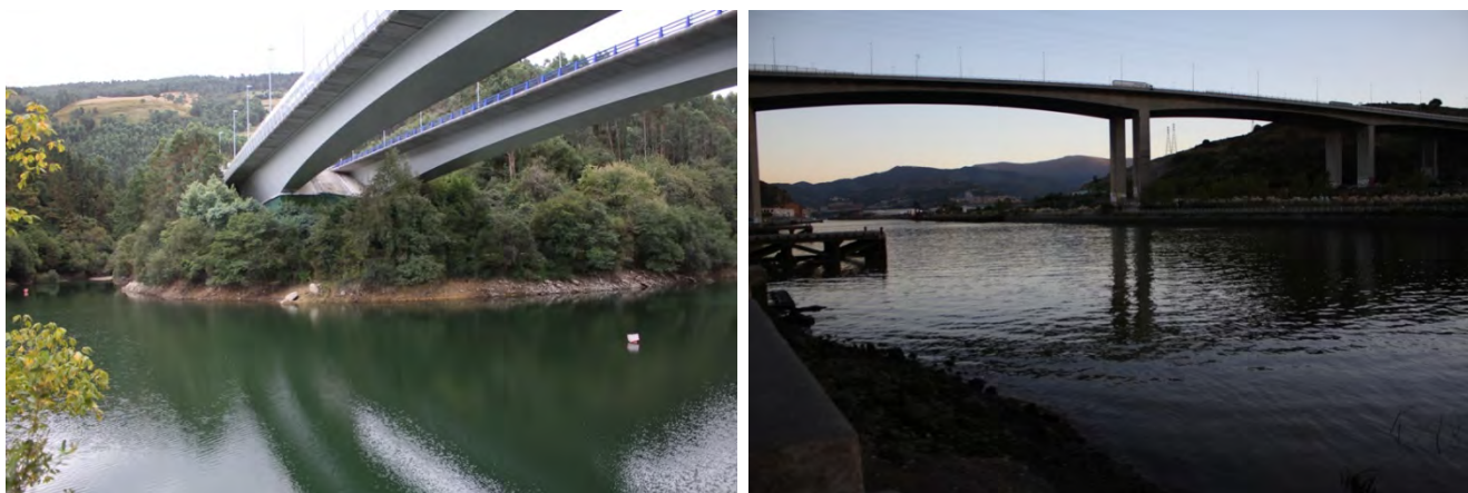
Fotos. Diversos de los viaductos y puentes existentes en el ámbito de estudio, a menudo con gran significación paisajística
