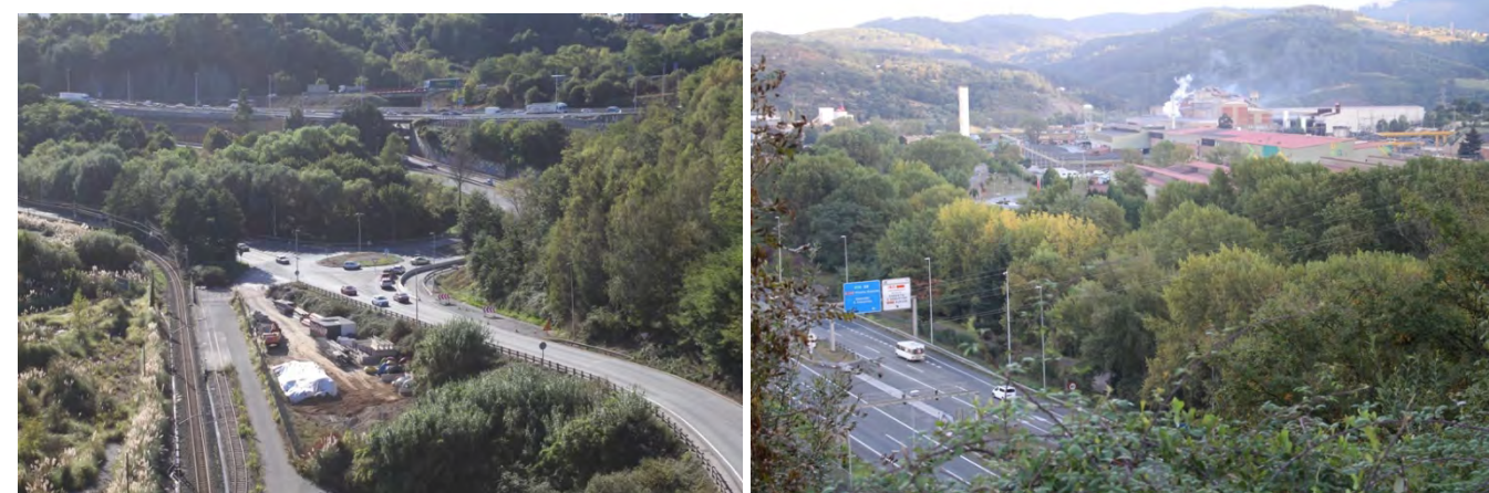
Fotos. Cruce de infraestructuras en Artxanda, y vista parcial de la AP-68 entre Arrigorriaga y Basauri
