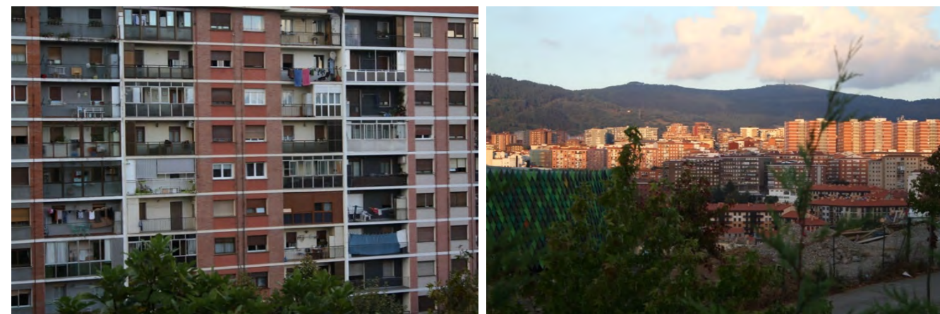
Fotos. Detalles de fachada de bloques residenciales, y zona de crecimiento en bloques observada desde Miribilla.
