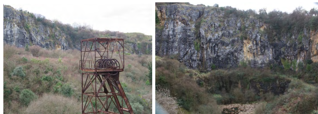
Fotos. Restos de castillete minero y cortas, en el caso de la derecha con un pequeño humedal.
